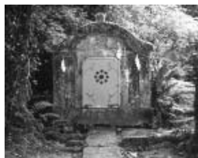
轟泉水道の取水口（轟水源）
